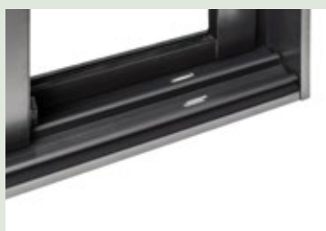
Drenering av bunnskinne til skjult dreneringskanal
